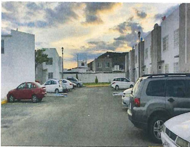
INFRAESTRUCTURA DE LA CALLE
